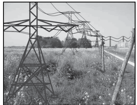
na aanleg van de 380kV kabels
